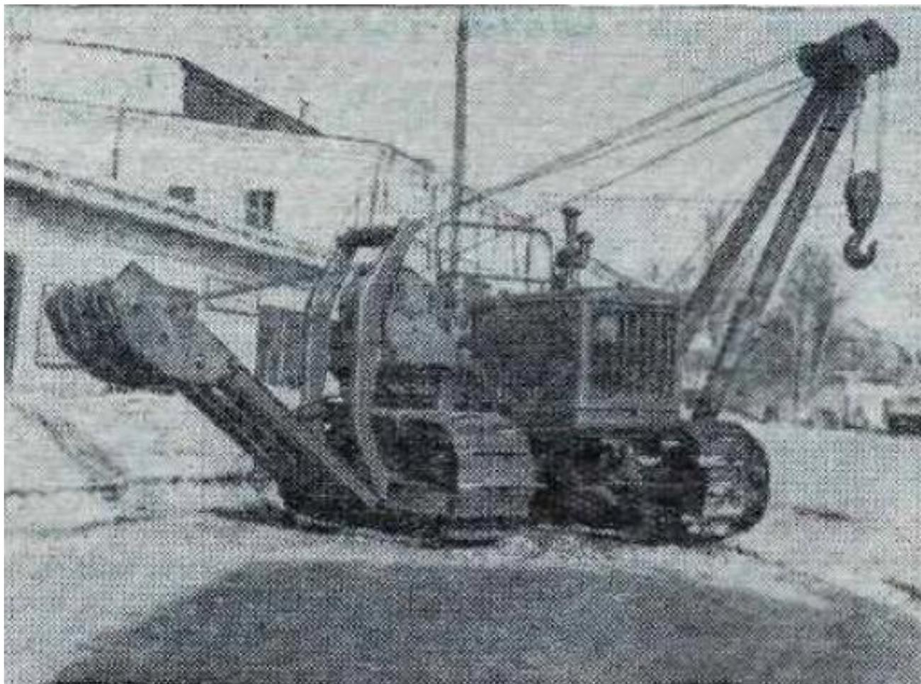
На этом снимке вы видите трубоукладчик Т 15–30. Он уже прошел расширенные заводские испытания и сейчас мы полностью уверены, что коллектив завода выпускать эти хорошие машины может. Сегодня мне хочется рассказать, как создавался трубоукладчик Т 15–30. На первом техническом совещании, где мы обсуждали конструкцию и намечали пути изготовления первого опытного образца, стало ясно, что создание новой машины потребует мобилизации творческих сил всего коллектива завода.
